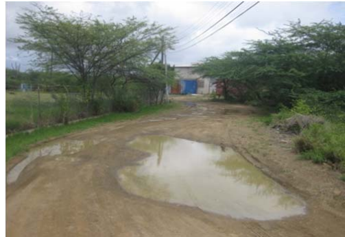
Figuur 32. Afwateringsproblemen Kaya Gavilan
